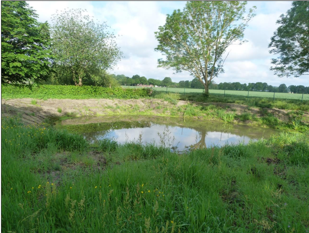
Abbildung 5 Regenrückhaltebecken im Mai 2022 nordöstlich an das Plangebiet angrenzend
